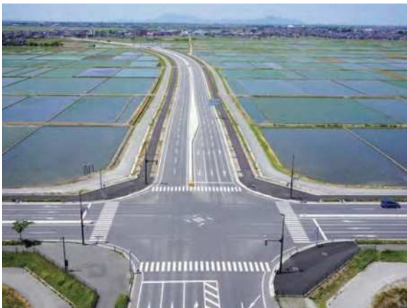
新潟中央環状道路 横越バイパス
