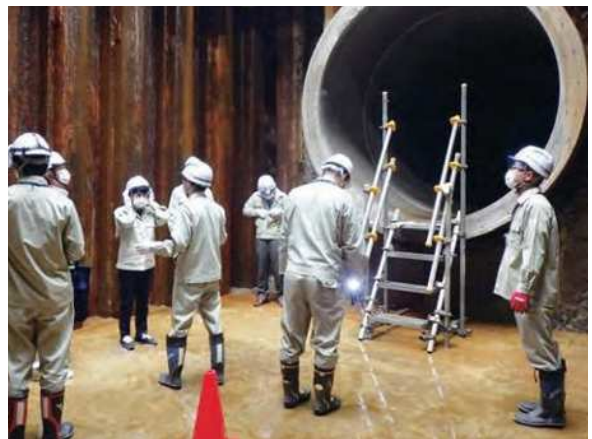
雨水貯留施設の整備
