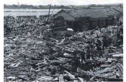
伊勢湾台風の被害状況 (写真提供: 愛知県)
