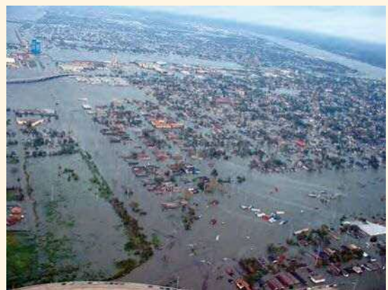
ハリケーンカトリーナによる被災状況 (出典: 米国連邦緊急事態管理庁(FEMA) ホームページ)
