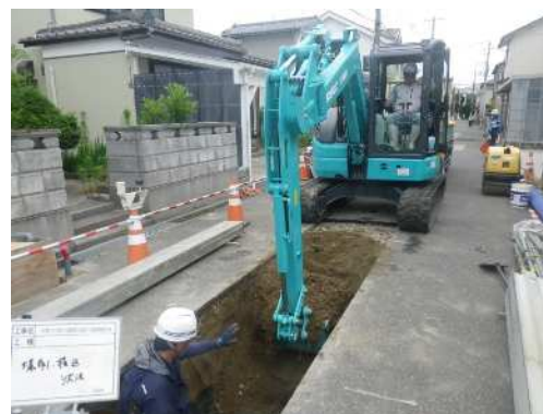
<管路掘削状況>
