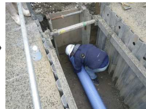
<管路布替え状況>
