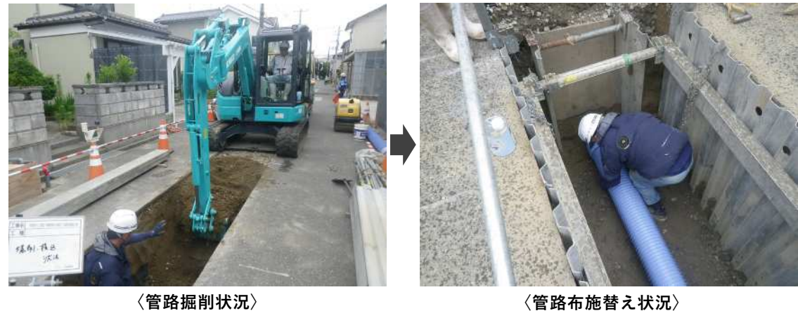
< 下水道の復旧イメージ >
