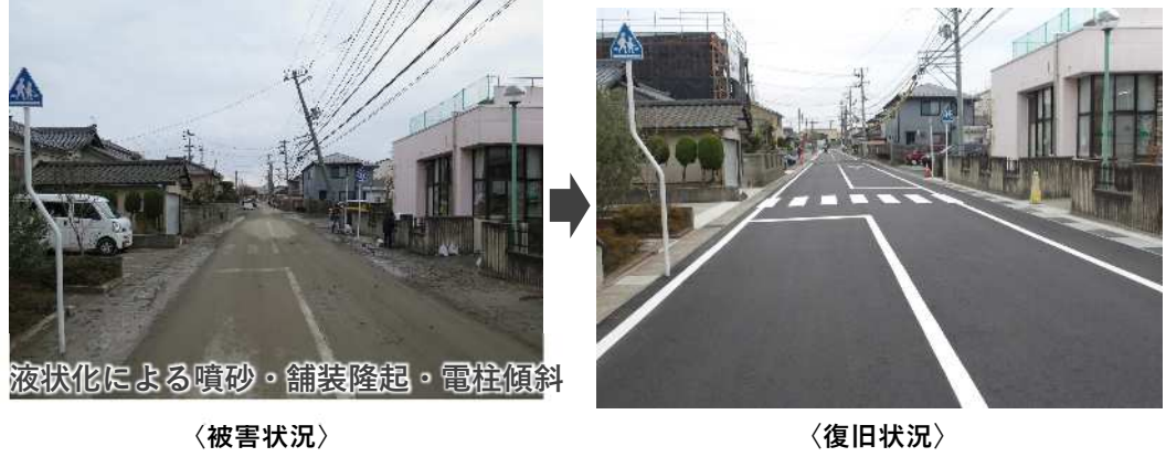
< 復旧状況（西区ときめき西） >
