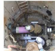
② 集水管設置狀況
