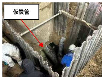
下水道管応急措置完了
