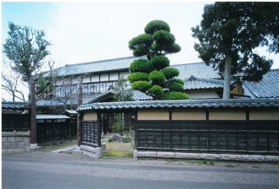
①笹口家住宅主屋 外観
