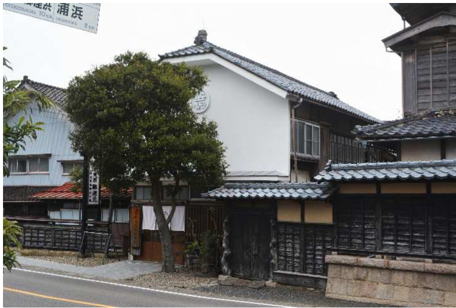
②笹祝酒造事務所棟 外観 手前の通りが旧北国街道で、写真左に大きな切妻、写真中央に半切妻の妻面を望む (写真右は笹口家住宅主屋)
