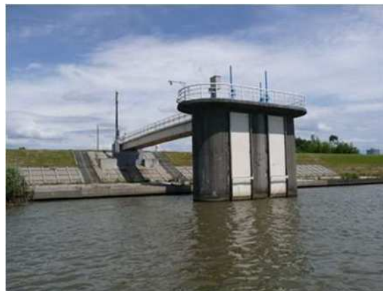
▲信濃川取水塔（新潟市水道局）
