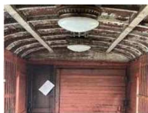
荷物室天井塗装 施工前
