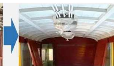
荷物室天井塗装 施工中
