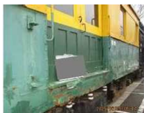
モワ 51 号外板 施工前
