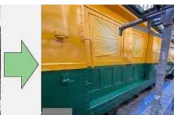
モワ 51 号外板 施工中
