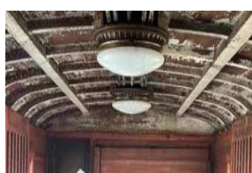
モワ51号荷物室内(施工前)
