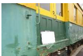
モワ51号外板(施工前)
