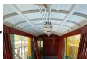
モワ51号荷物室内(施工中)
