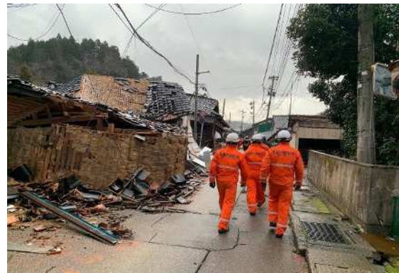
▲能登半島地震での被害状況
