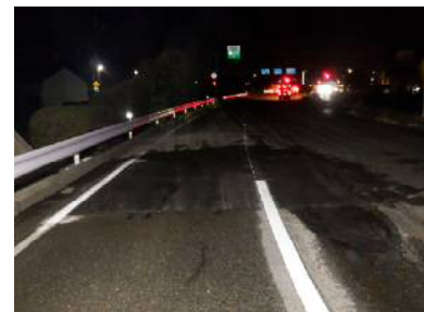
路面復旧状況
