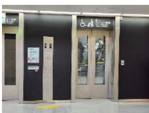
写真 42 車椅子対応エレ ベーターの設置
