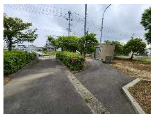
写真 40 園路の 段差解消
