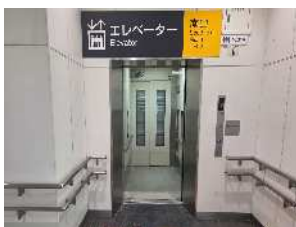
写真33 エレベーターの設置
