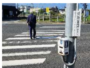
写真 45 青延長用押しボタン 付き信号機の設置
