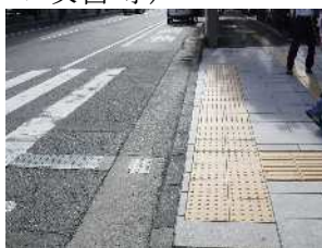
写真36 車道との段差解消
