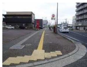
写真37 視覚障害者誘導用ブロックの設置
