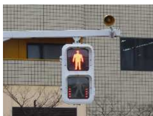
写真 44 音響式信号機 の設置
