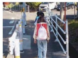
通学路の防護柵設置
