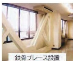
下水処理場の耐震化
