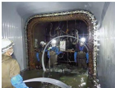
下水道管渠の改築工事
