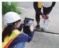
タブレットを用いた点検
