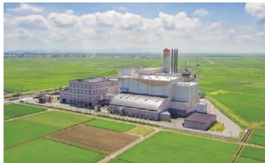
新田清掃センター（ごみ焼却発電所）
