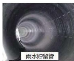
浸水対策施設の整備
