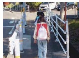
通学路の防護柵設置
