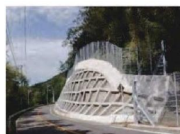
法面对策工事（施工後）
