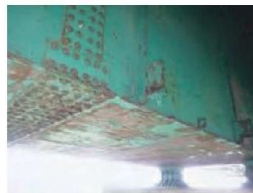
主桁の腐食
