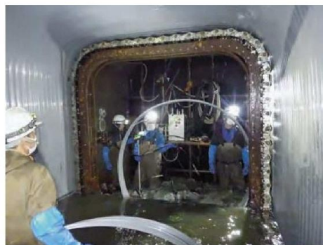
下水道管渠の改築工事
