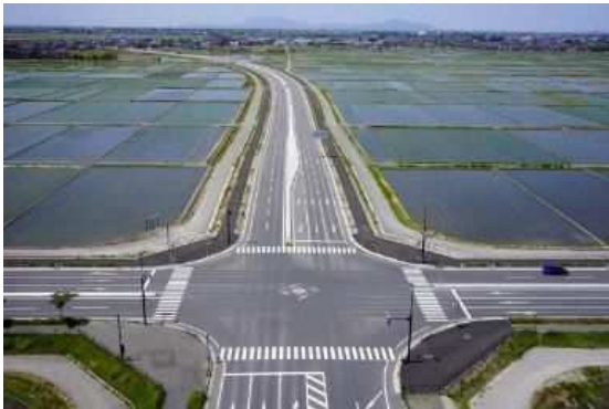
新潟中央環状道路 横越バイパス
