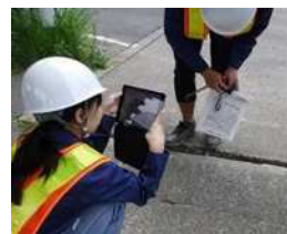
タブレットを用いた点検
