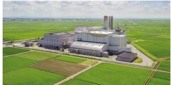
新田清掃センター(ごみ焼却発電所)
