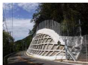
法面对策工事(施工後)
