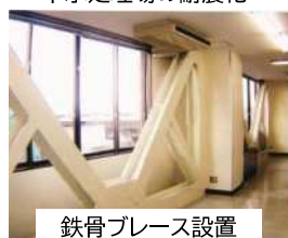
下水処理場の耐震化
