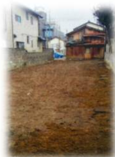
除却後の状況
