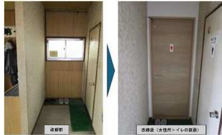
女性活躍促進に向けた環境整備 （女性用トイレの新設）
