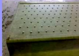
滑り止め用突起の設置
