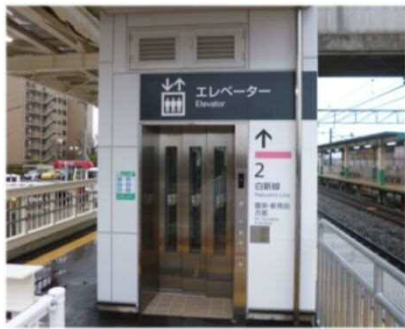
エレベーター設置(JR東新潟駅)
