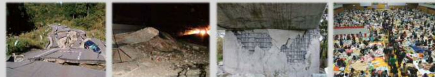
写真：左から 陥落した国道253号（旧新潟県堀之内上稲倉）、国道17号和南津トンネルのコンクリート剥落、国道17号小千谷大橋橋脚の破損、被災3日目の避難所
