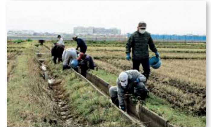
水路の目地詰め
