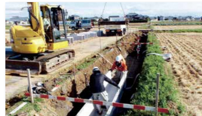
排水フリウム布設
