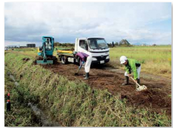
農道の軽微な補修等(古津環境保全会)
