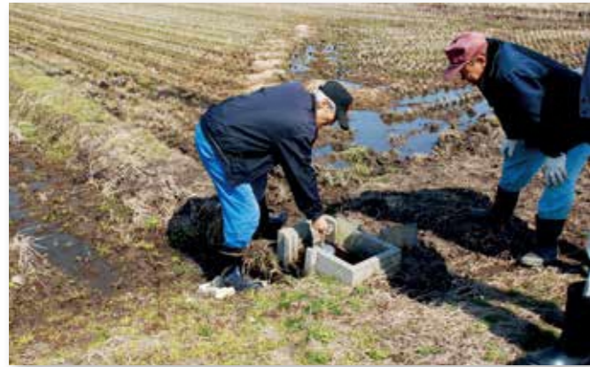
施設の点検(小鹿農地・水保全管理組合)
