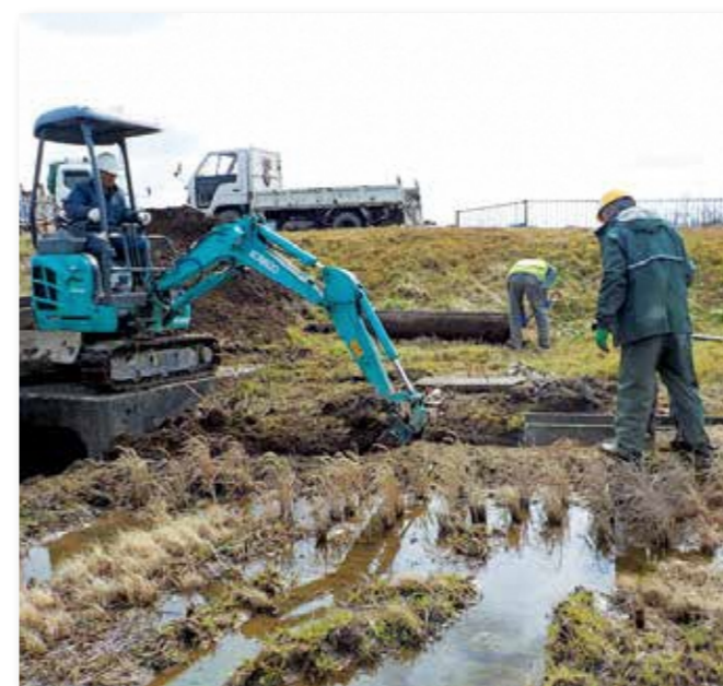
水路の軽微な補修 U字溝敷設替え
