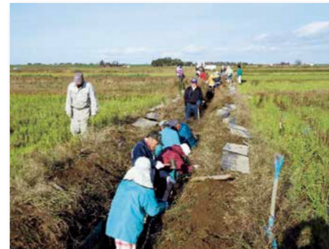
波板を設置 水路への土砂の流入を予防します
