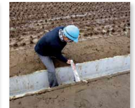
管理の省力化を目指し、土水路をフリーム化 自主検査で施工状況を確認
