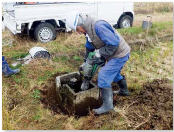
水路の軽微な補修(市之瀬環境保全協議会)
