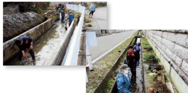
小水路は農家組合で、宅地排水が流入する排水路は地域全員で泥上げ
