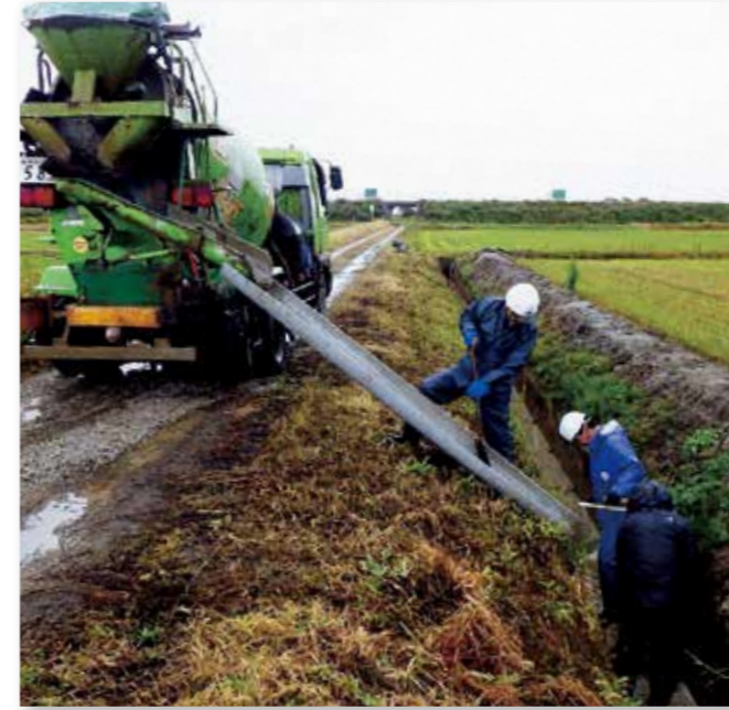
排水路の底打ち
