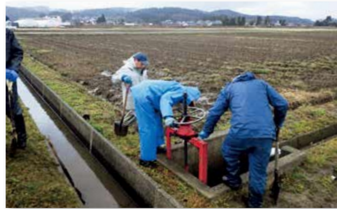
水路附带施設の保守管理(新関保全会)
