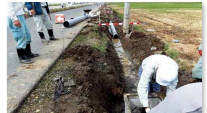
用水路のパイプライン化
