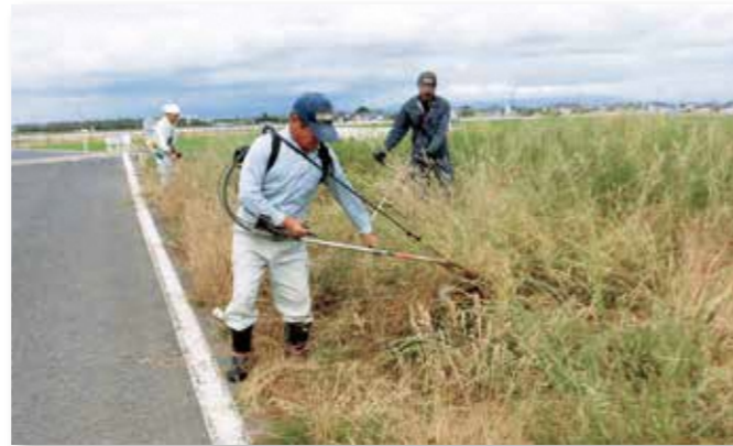
路肩・法面の草刈り
