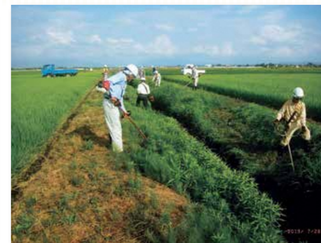
排水路の草刈り
