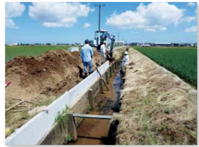
水路の軽微な補修(荻島中野田島環境保全組合)
