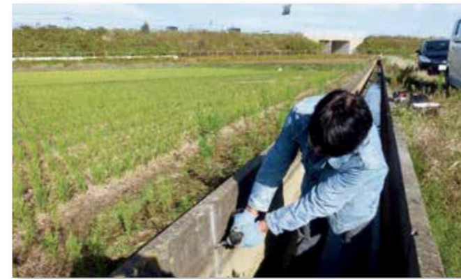
水路の目地詰め
