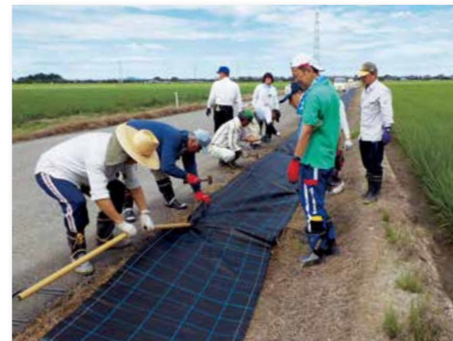
防草シートを設置して雑草対策
