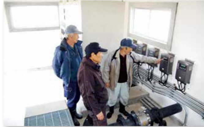
施設の点検(湯川水辺保全会)
