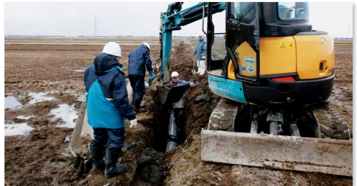
用水パイプラインの自主施工
