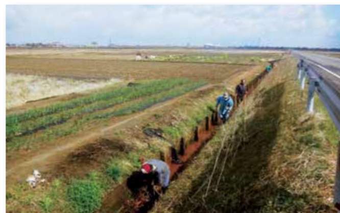
排水路の泥上げ
