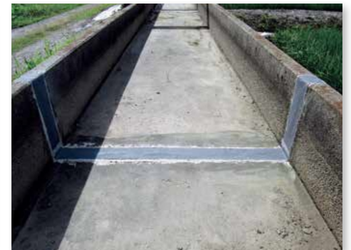
用水路の漏水補修
