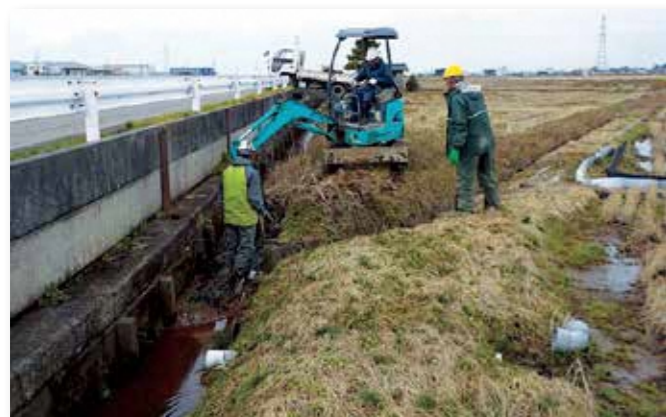
排水路の泥上げ
