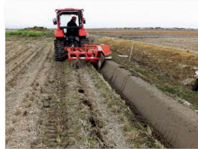
畦畔を補修し、田んぼダムの取組
