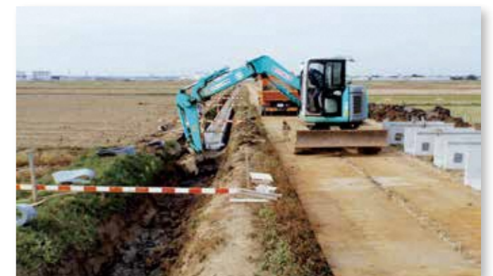
素掘り水路をコンクリート水路に更新
