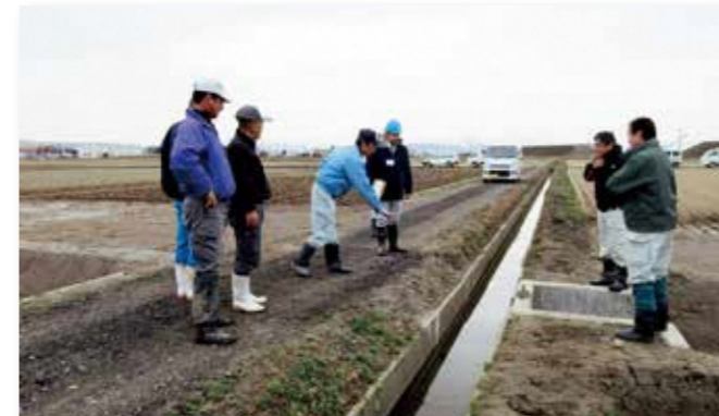
活動組織による竣工検査
