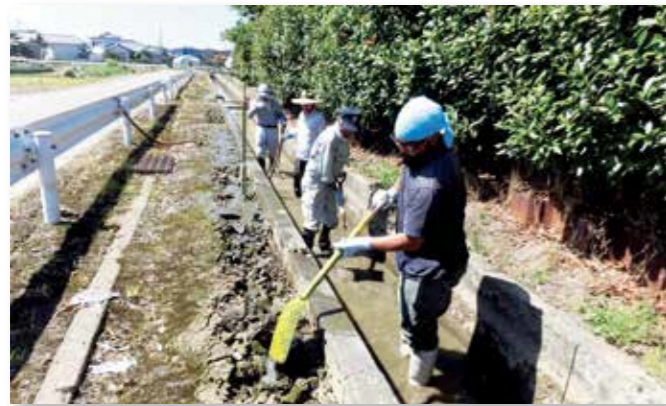
水路の泥上げ
