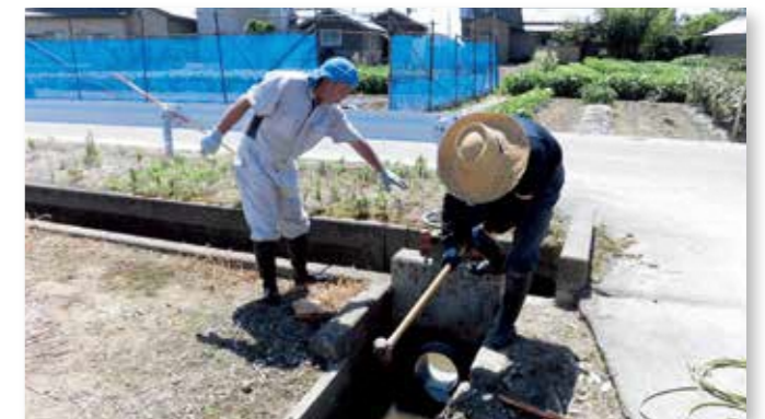
用水路水門の補修
