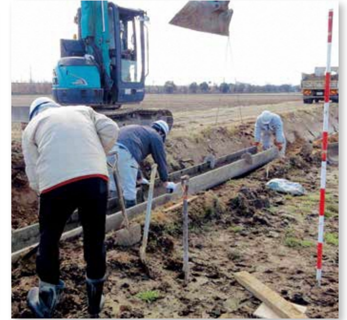
既設U字フリュームの再布設による不同沈下区間の解消
