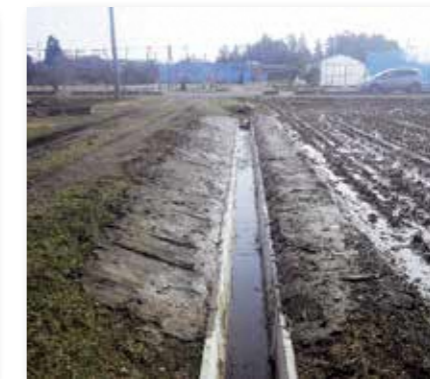
管理の省力化を目指し、土水路をフリーム化 自主検査で施工状況を確認
