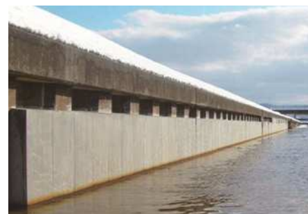
鋼矢板水路の腐食対策
