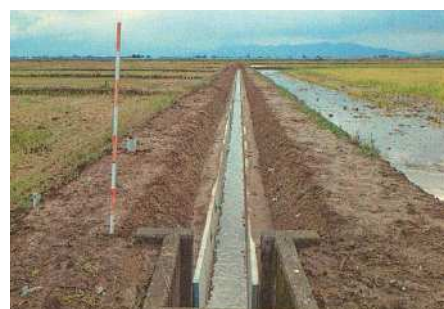
土水路から排水フリュームへの更新
