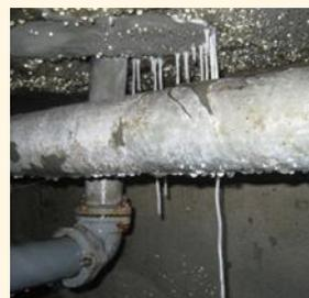
◀ 給排水管の腐食等により著しく衛生上有害となるおそれがあるマンション
