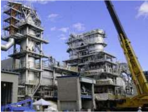
■ ごみ発電施設の建設風景
