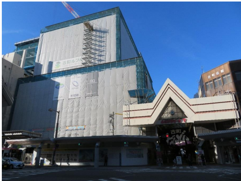
建設中の再開発ビル（古町ルフル）
