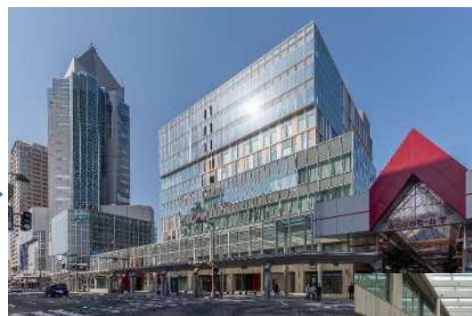
共同建替えにより 新たな都市機能を導入し、 空地（広場）を整備
