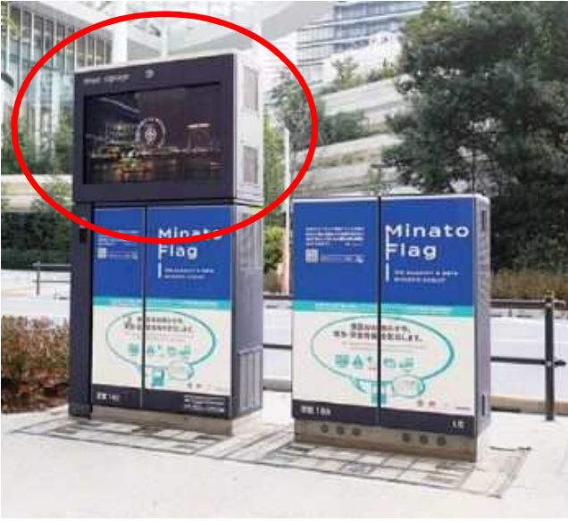
路上変圧器へのデジタルサイネージ設置 (東京都港区、国土交通省HPより)
