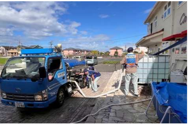
福祉施設の仮設水槽への注水
