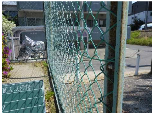
ボルト処置後
