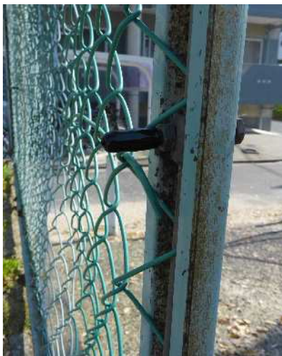
ボルト応急処置状況
