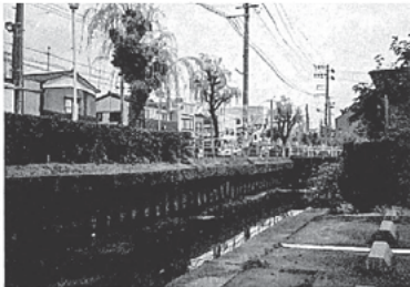
川の両側で堤防の高さが違う。 もし水があふれたらどうなるだろう。
