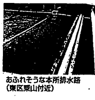
あふれそうな本所排水路(東区栗山付近)
