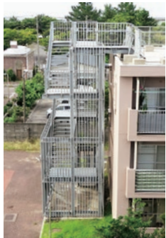
津波避難対策として避難階段を整備した市営船江町住宅
