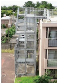
津波避難対策として避難階段を整備した市営船江町住宅
