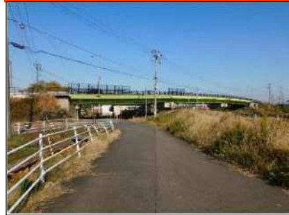
新大通川橋 (漆山) 99m
