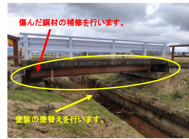
当て板補修工、塗装塗替工
