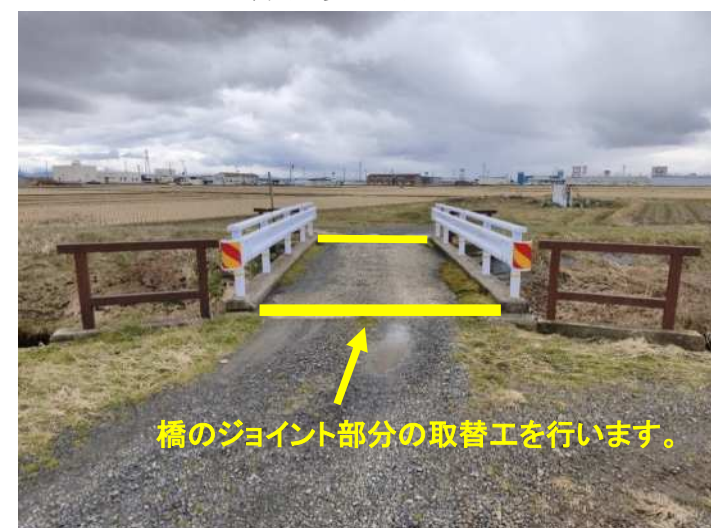
伸縮装置取替工
