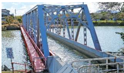
川と川の立体交差。新川の上の水路橋を西川が流れる。上皇陛下は皇太子時代に見学された。
