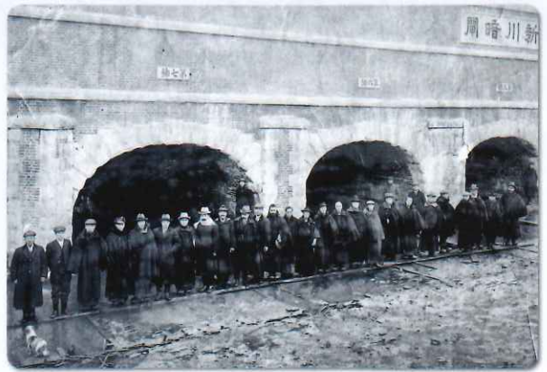
1913年完成のレンガ×鉄筋コンクリート製の9門暗闇(あんこう)。トンネル部分は高さ3m、長さ67m。底樋に比べ、排水能力は飛躍的に向上した。
