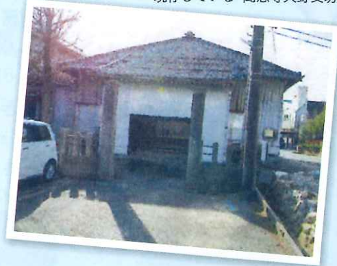
現存している「聞念寺大野支坊」
