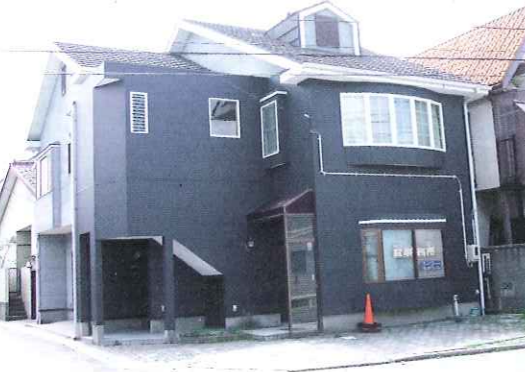
借上げ事務所外観(402号線より観る)
