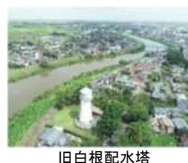
旧白根配水塔
