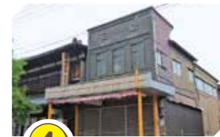
4 看板建築の町屋 (五六の町など)
