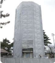
工事中の旧白根配水塔
