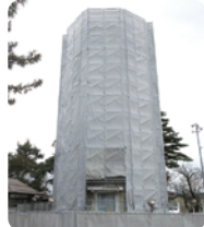
工事中の旧白根配水塔
