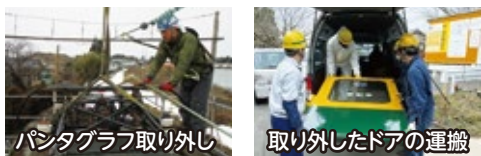
パンタグラフ取り外し
