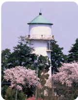
旧白根配水塔
