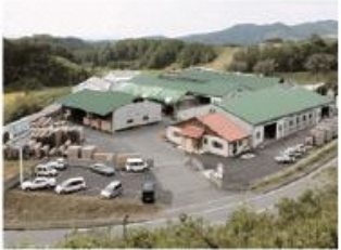
多良木プレカット工場
