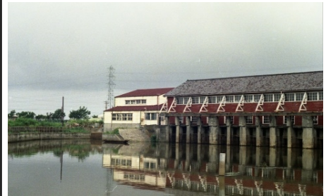
栗ノ木排水機場（1948年完成） 所蔵：亀田郷土地改良区
