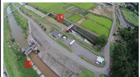
①新樋曾山隧道 ②新々樋曾山隧道
