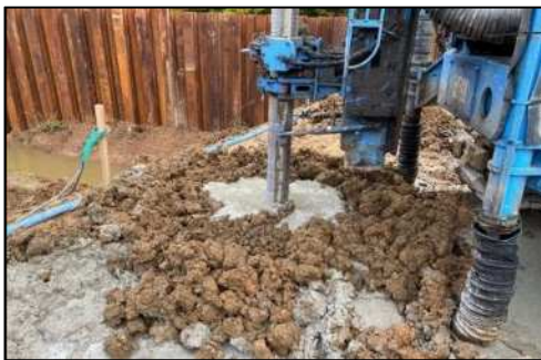
◀沈下防止工事の工事中写真の例
