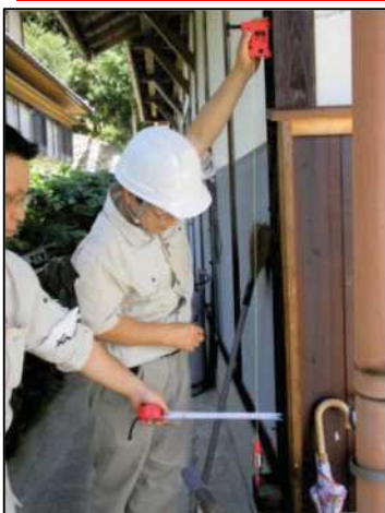
◀家の傾斜を測定している写真の例
